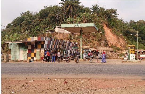
Figure 4 : Station AFRIGAZ avant l'effondrement à Gauche Vs
