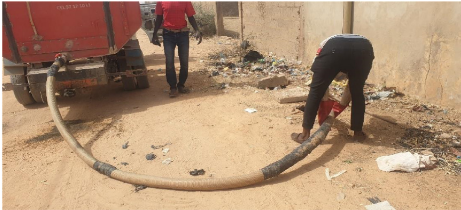
Photo 2 : vidange mécanique des eaux usées d'une fosse septique
