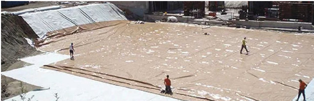
Figure 08 : Pose de membrane étanche à l'air
