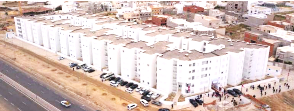
Figure5. Logements sociaux construits dans le cadre de la coopération tuniso-saoudienne à Kairouan (Presse tunisienne)
